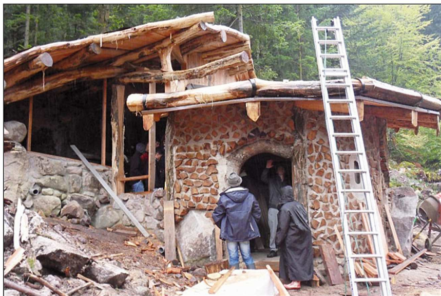
Un chantier passionnant et riche d'enseignements
